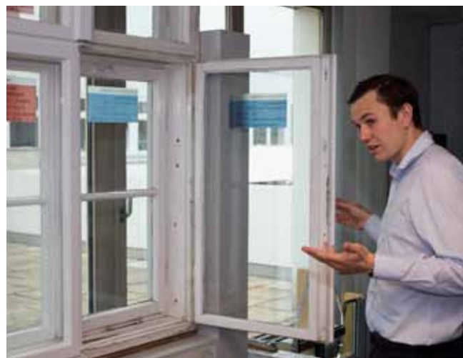
À gauche : Fenêtre témoin intégrale en bois pour la résidence de l'ambassade d'Allemagne. À droite : Bastian Timm explique les mesures d'assainissement intégral à partir d'un élément d'exposition.
