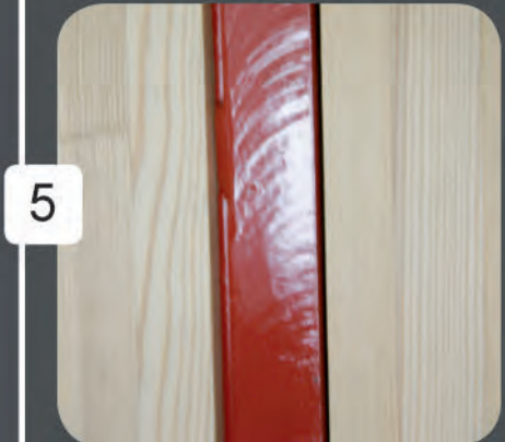
Vorgefräßte, paßgenaue Stahlprofile
