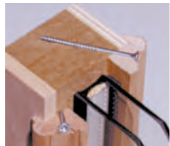
Befestigung der Glas- und Füllungshalteleisten: Einleimen, Nageln oder Verschrauben (Mindesteinschraubtiefe 40 mm)
